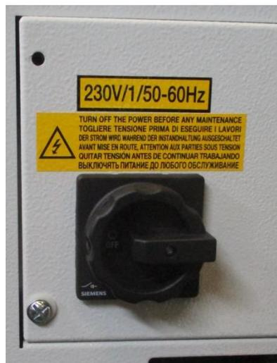
Abbildung 12 – Hauptschalter in der Stellung „OFF“ (AUS)
