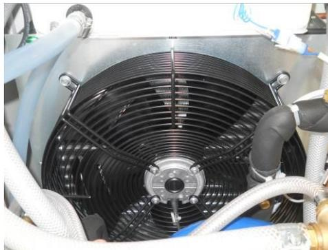
Abbildung 18 – Einbaulage des Ventilators
