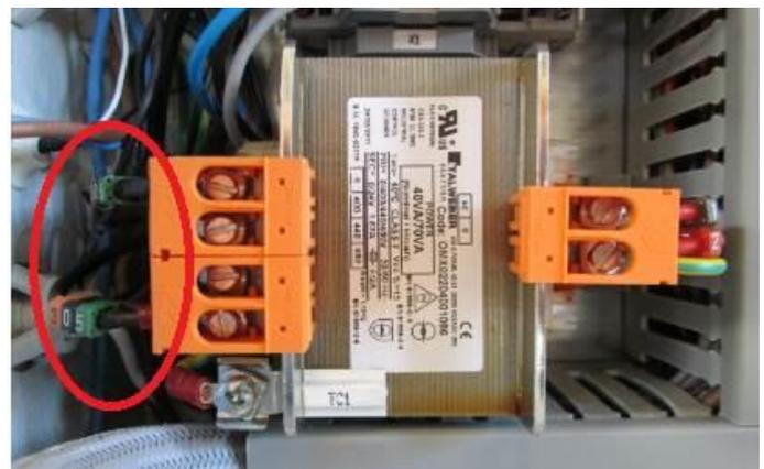
Abbildungen 5+6 – Transformator auf 400 V-Einstellung (links) und auf 460 V-Einstellung (rechts)
