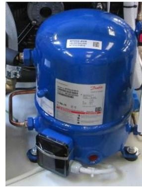
Abbildung 17 – Einbaulage des Verdichters, nBoxX 3.5 , nBoxX 5.0 , nBoxX 6.5
