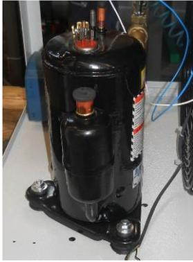
Abbildung 16 – Einbaulage des Verdichters, nBoxX 1.7
